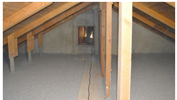
iCell Lösull ger isoleringsskikt utan skarvar och materialet kan med fördel användas i både gamla och nya konstruktioner
