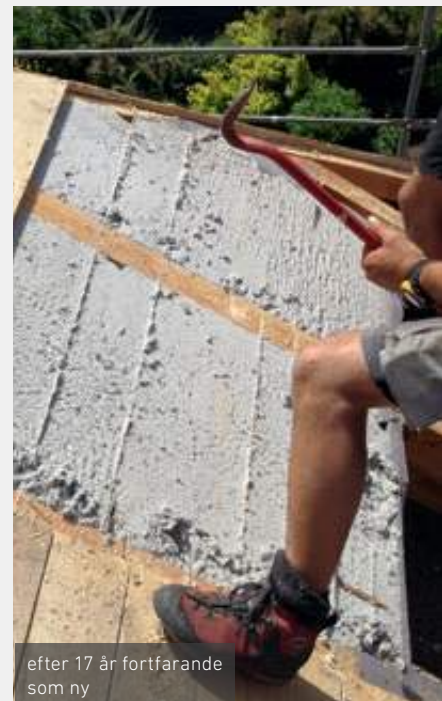
Känt sedan länge, tidningspapper transporterar fukt
